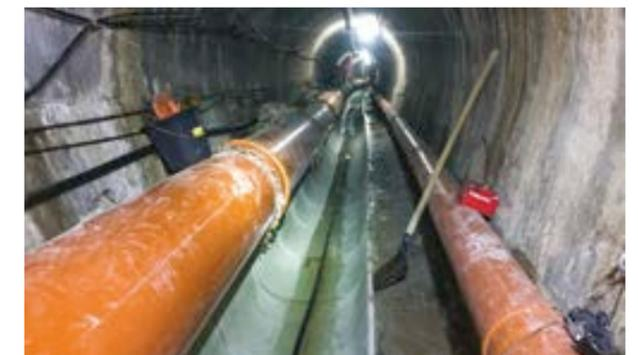
Les nouvelles cunettes sont en cours de pose sur les 1 300 m. En début d'année, des injections de coulis de ciment ainsi qu'un chemisage par béton armé seront réalisés pour renforcer les parois.
