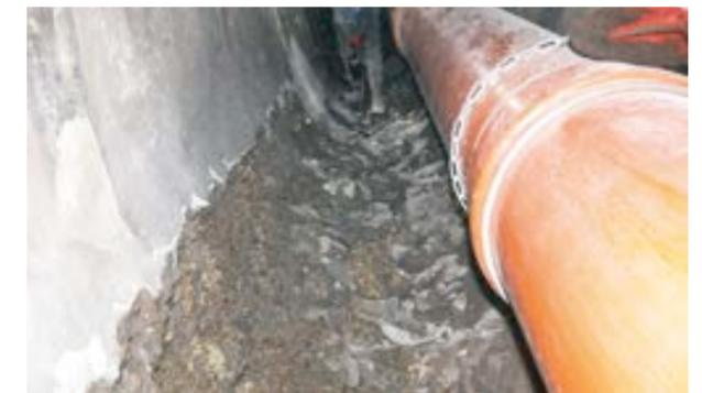
Deuxième étape : décapage à haute pression du radier (zone d'écoulement central de la conduite) et piquage du béton altéré. Les 160 branchements raccordés ont également été diagnostiqués.
