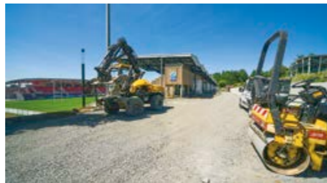
Phase 2 des travaux de Jean Alric
