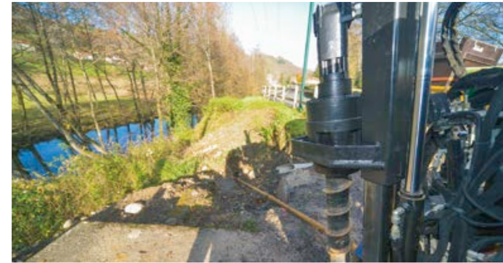
Un forage dirigé pour passer sous la rivière
