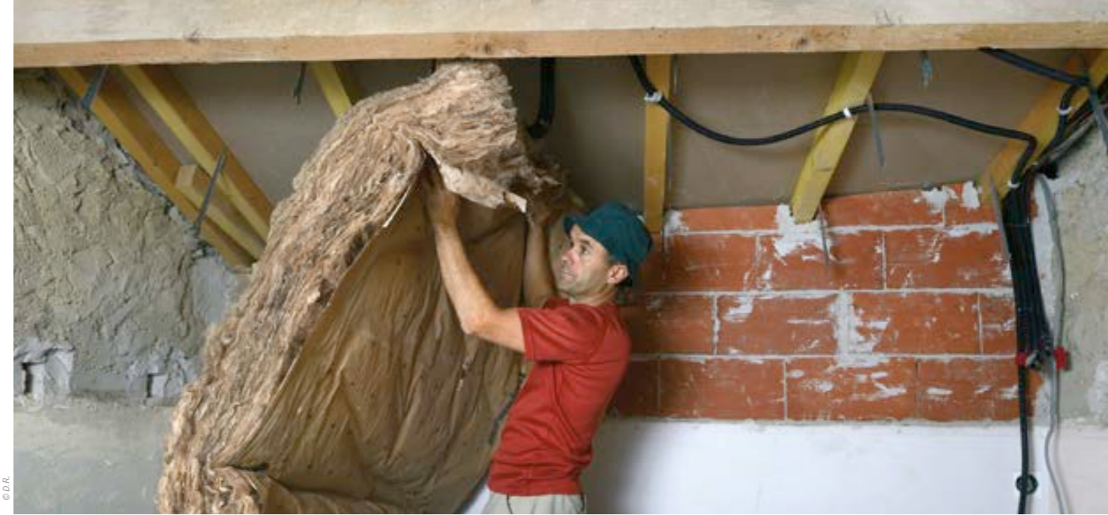
L'isolation des combles peut faire partie des travaux éligibles
