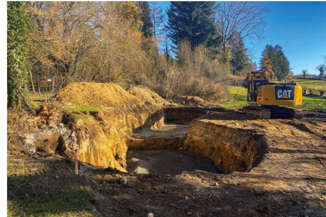
Creusement de l'espace qui va accueillir l'observatoire semi-enterré et l'escalier
